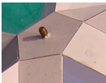
Bild: eingebaute Schraube zur Befestigung der oberen Spitze mit Kabelzuführung.
